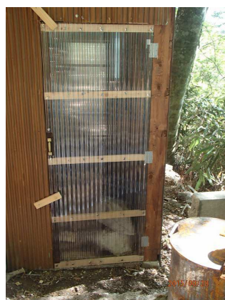
焼却炉側の入口扉
