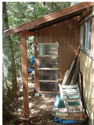
便槽側の入口扉
