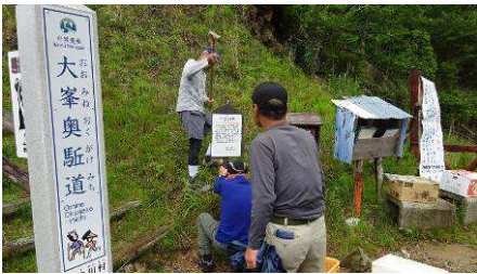
荷揚げ協力依頼の看板設置
