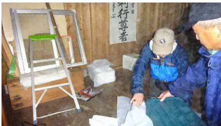
灌頂堂にセメント保管
