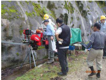
ワイヤーにカシメ金具取付け モノレール試運転
