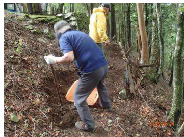
管理棟発電機室下・奥駆道の土留め横棧木取替え
