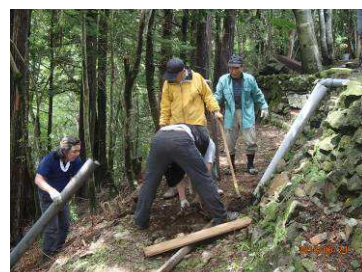
奥駆道を横切る排水トユパイプに踏板設置
