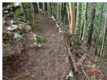
管理棟発電機室下・奥駆道の土留め横棧木取替え
