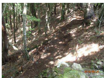
北側奥駆道に土留め横棧木設置
