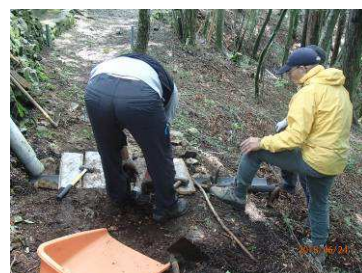
奥駆道を横切る排水トユパイプに踏板設置
