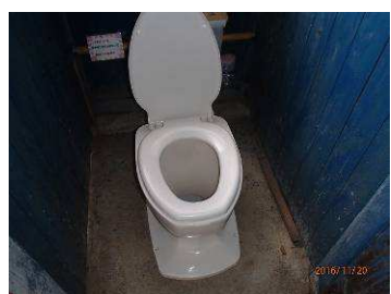
腰掛便座を据置
