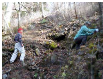
水場径の整備改修作業
