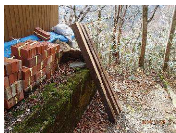
トイレ拡幅の柱調達
