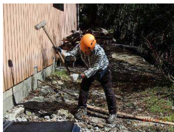
東側犬走り再舗装の為、舗装面を割り砕き砕石敷き
