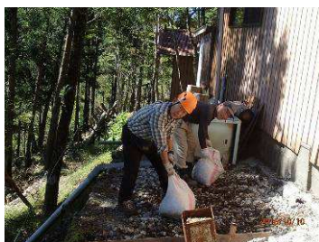
東側犬走り再舗装の為、舗装面を割り砕き砕石敷き
