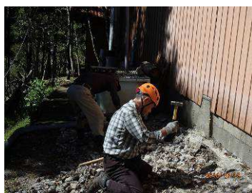
東側犬走り再舗装の為、舗装面を割り砕き砕石敷き
