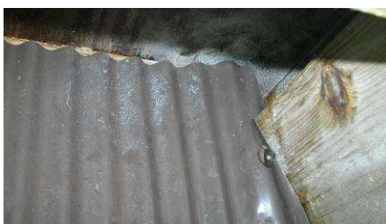
外壁トタン復旧
