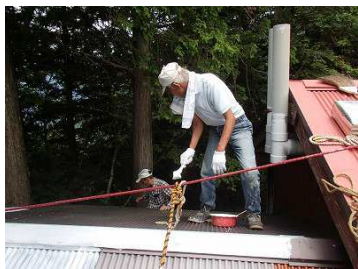
新規玄関屋根下塗り
