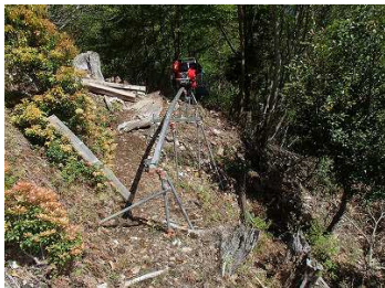
モノレール終点補修前 プラットホーム高さ調整 終点・3段の土留め
