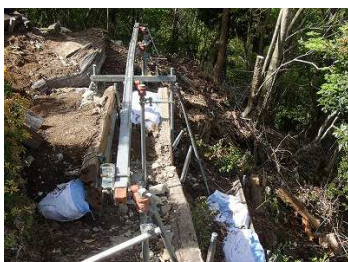
モノレール終点補修前 プラットホーム高さ調整 終点・3段の土留め
