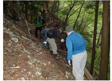
栈木打込み後の道ならし
