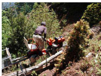
モノレール終点補修前 プラットホーム高さ調整 終点・3段の土留め
