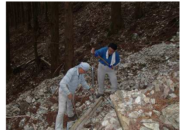
鋼管杭打込み作業
