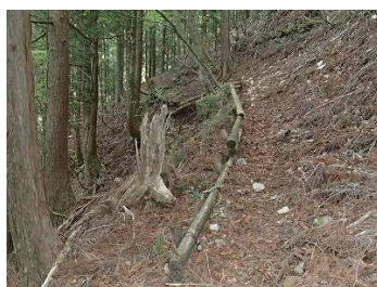
栈木打込み後
