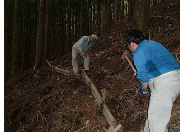
浮いた栈木・倒れた栈木改修作業中
