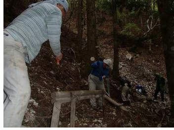
浮いた栈木・倒れた栈木改修作業中
