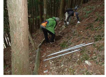
栈木改修後の土寄せ
