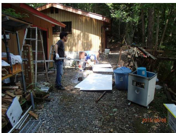
計測寸法に石膏はボード切る
