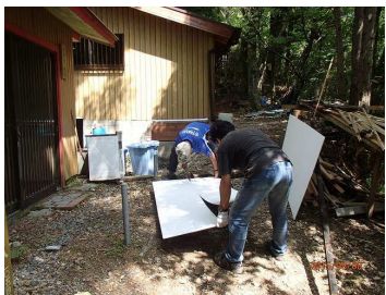
計測寸法に石膏はボード切る
