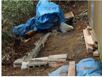
天井板に切り端材切断 ブロック基礎完了
