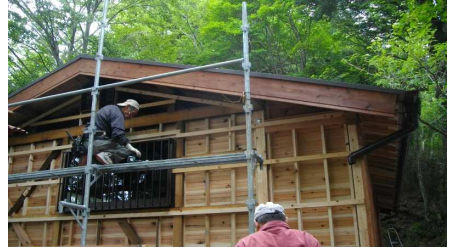
外壁の下地作り
