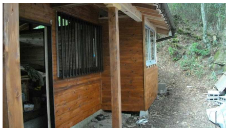
柱と同色で塗装
