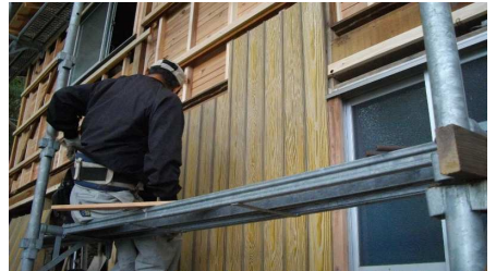
プリント鋼板の取り付け
