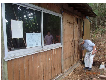
腐朽の外板壁撤去中 外板壁撤去 外板壁撤去と石積作業
