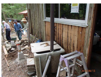
腐朽の外板壁撤去中 外板壁撤去 外板壁撤去と石積作業
