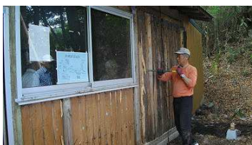
腐朽の外板壁撤去中 外板壁撤去 外板壁撤去と石積作業
