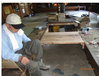
完成した移動式渡り廊下
