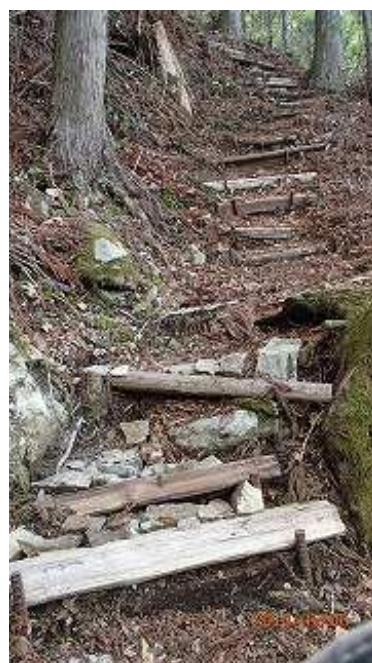
補給路第一ベンチ下の段差改修(電柱廃材使用)
